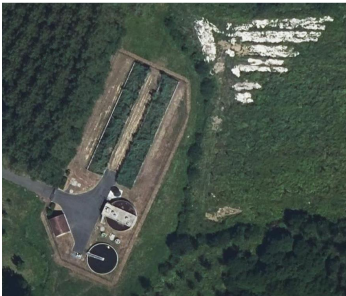
Figure 1 : Vue aérienne de la station d'épuration (Source geoportail.fr)
